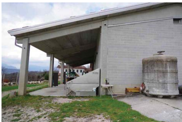
4. Prospetto sud cantina (2 di 2).
