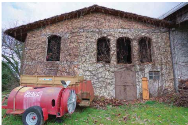
19. Annesso rustico, fienile piano primo.
