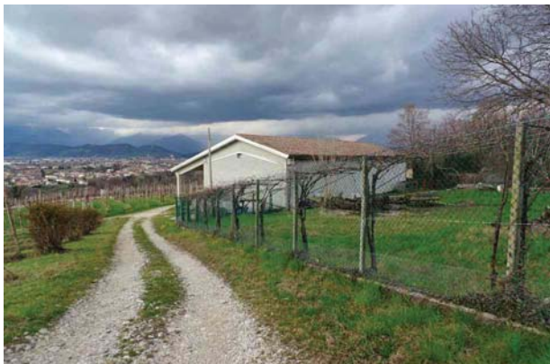
1. Ingresso da Via Canova, non recintato (1 di 2).
