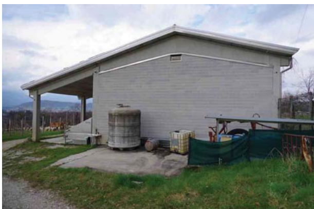
3. Prospetto sud cantina (1 di 2).
