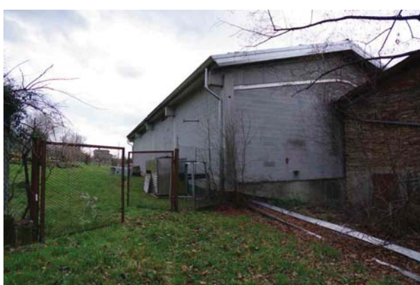
22. Cantina, prospetto sud est.
